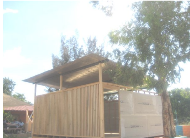
Casi ya terminamos de construir
