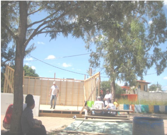
Construyendo nuestro primer salón de clases
